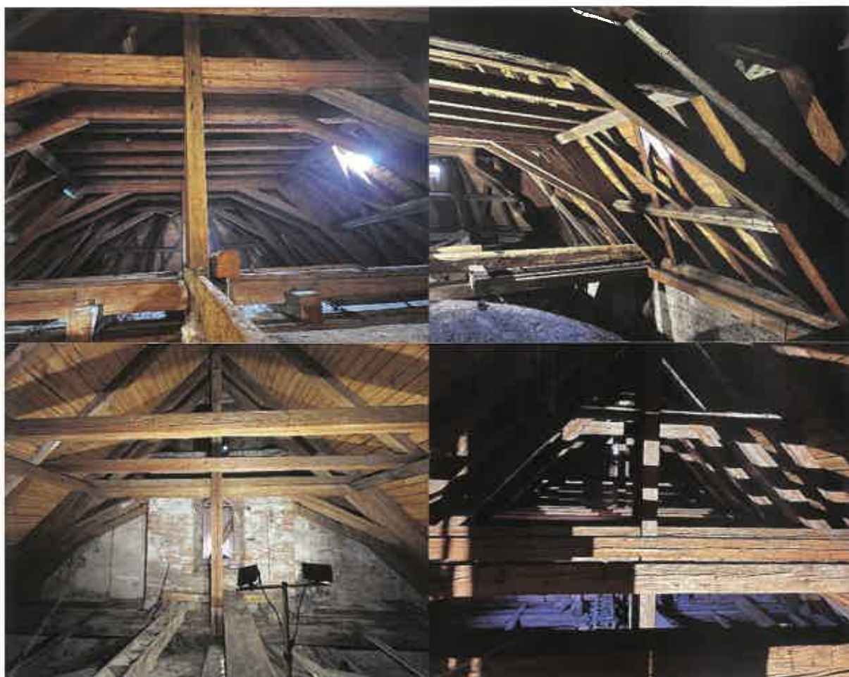
Obr. 2 - Pohled na konstrukce určené k chemickému ošetření
