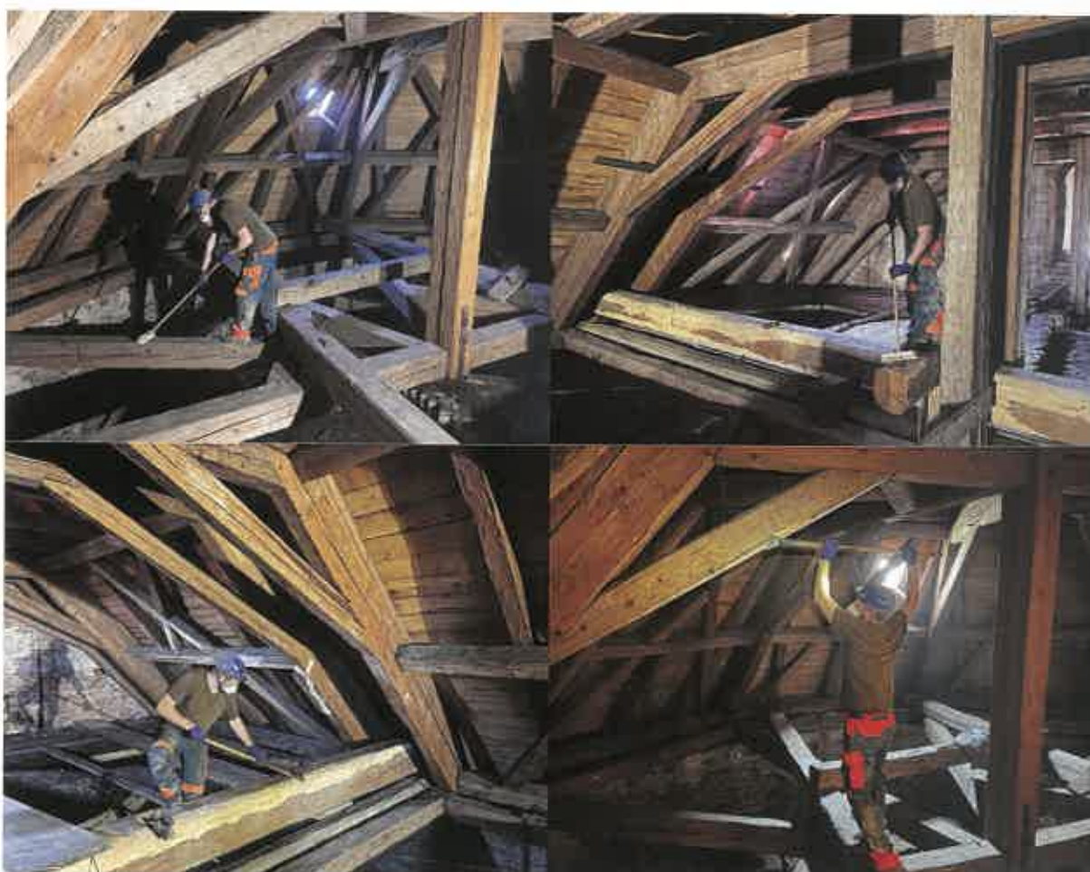
Obr. 5 - Předsanační příprava – očištění konstrukce; odstranění zbytků kůry
