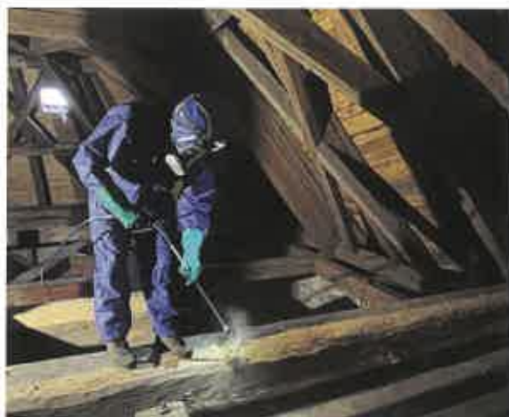
Obr. 6 - Aplikace chemické látky na přístupné dřevěné prvky krovové konstrukce objektu
