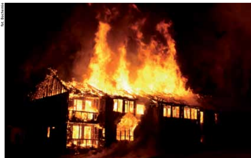
Produkty drewniane i drewnopochodne bez specjalnego zabezpieczenia zwykle osiągają klasę reakcji na ogień D-s2, d0, co oznacza, że do zapalenia może dojść w ciągu 2 do 10 min od początku pożaru.
